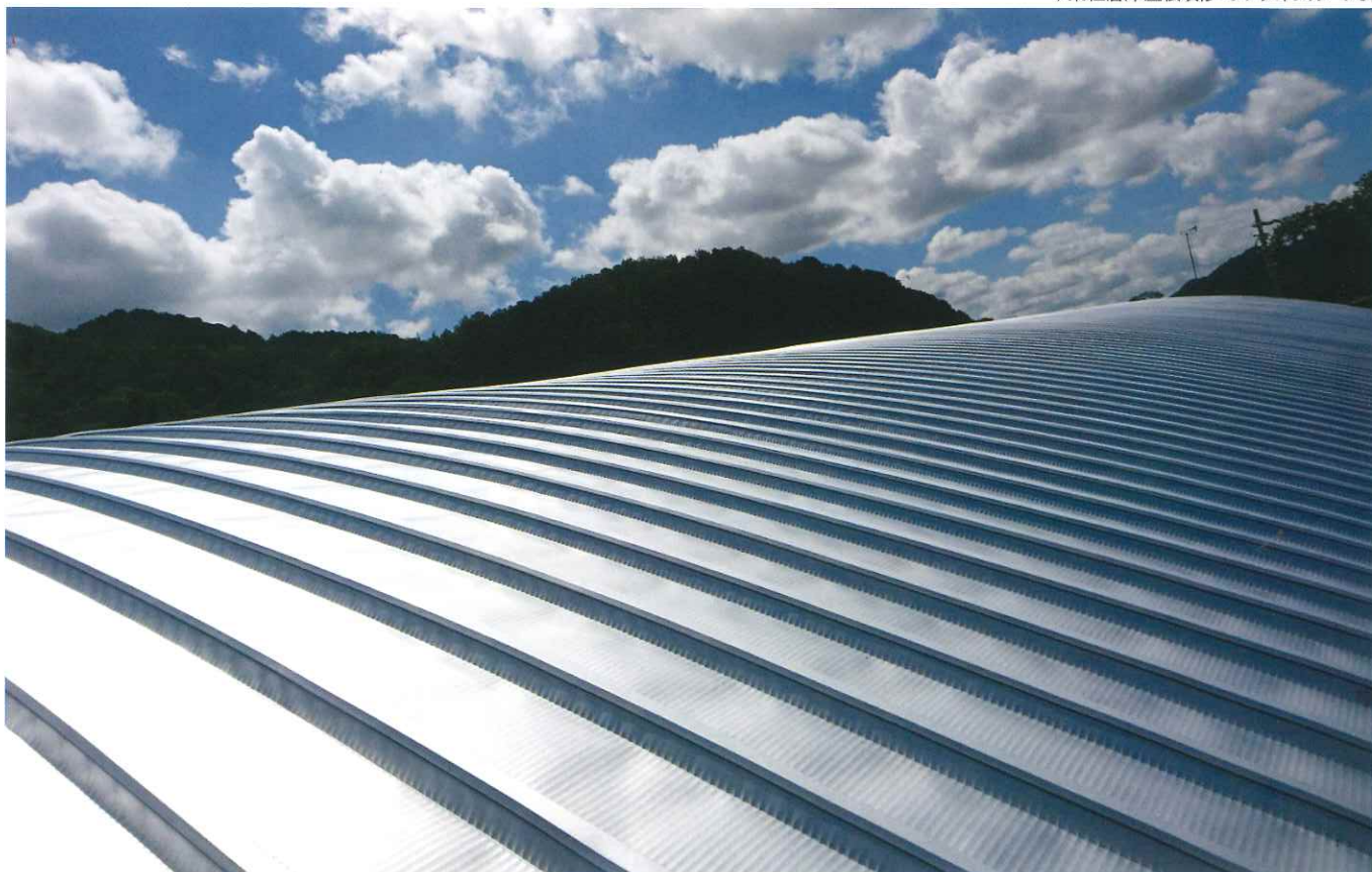
▼某社倉庫屋根改修：リファインルーフ66
