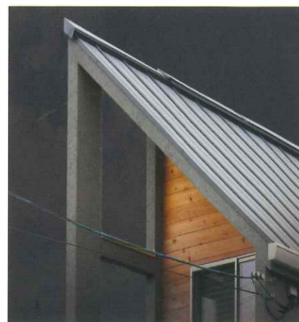
通気立平デネブアールーフ 施工事例
