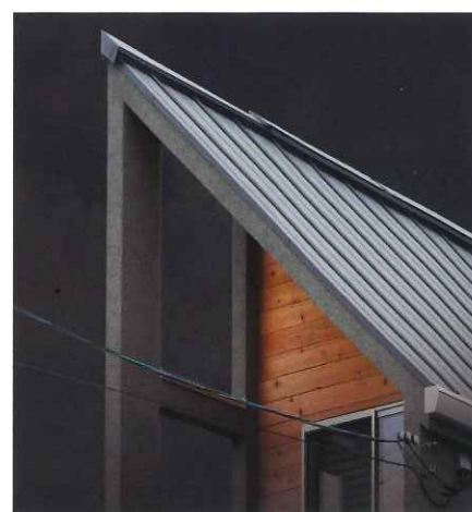
通気立平デネブエアルーフ 施工事例
