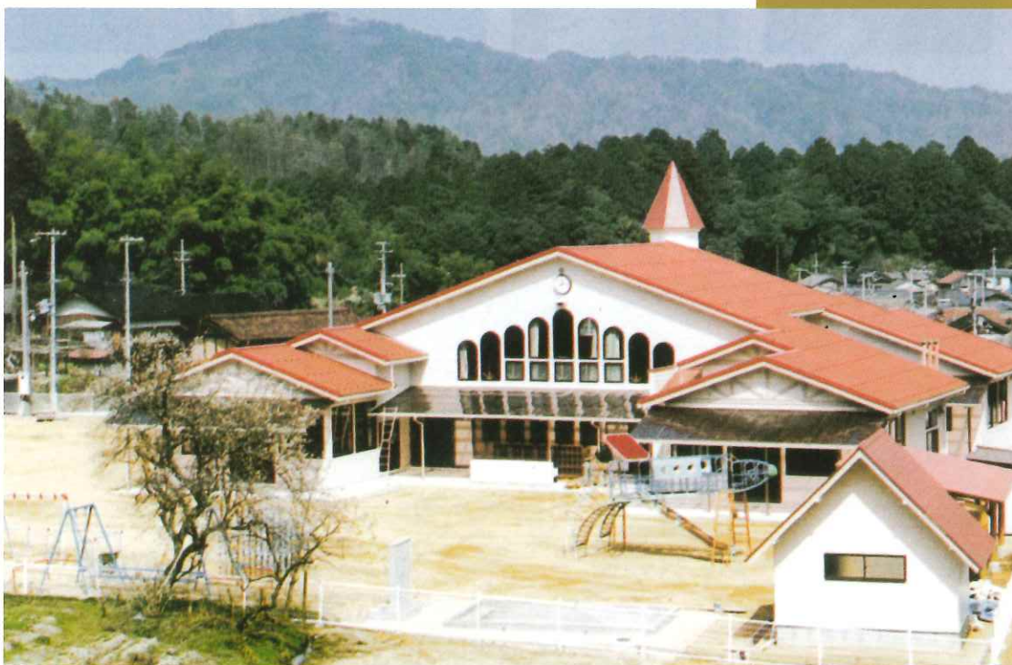
▲屋根改修：(上)K太くん (下)プレーゲル
