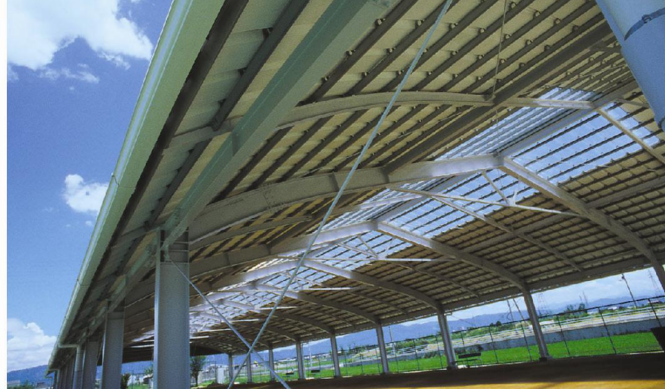
▲新設 / 奈良県磯城郡三宅町、三宅町中央公園ゲートボール・アーチェリーレンジ屋根（ガルバリウム鋼板使用、採光材ポリカ）
